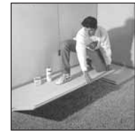
Rigidur padlóelemek fektetése
