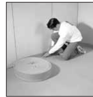
Hangszigetelő szalag elhelyezése
