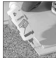
Rigidur ragasztó felhordása a falcban
