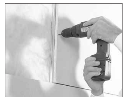
Rigidur lap rögzítése
