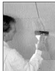
Fugák befejező glettelése
