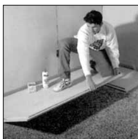
Rigidur esztrichelemek fektetése
