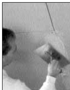
Fugák kitöltése Rigidur hézagoló gipsszel
