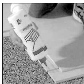
Esztrichragasztó felhordása a falcba
