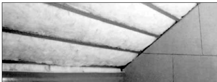
Fém vázszerkezet hőszigeteléssel
