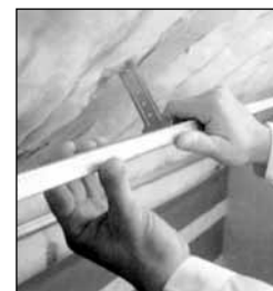
Fém vázszerkezet rögzítése
