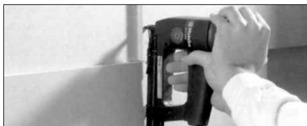
Második burkolati réteg rögzítése kapcsozással
