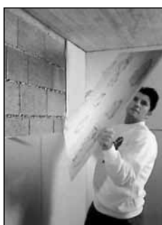
A szárazvakolat felhelyezése
