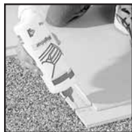
Rigidur ragasztó felhordása a falban
