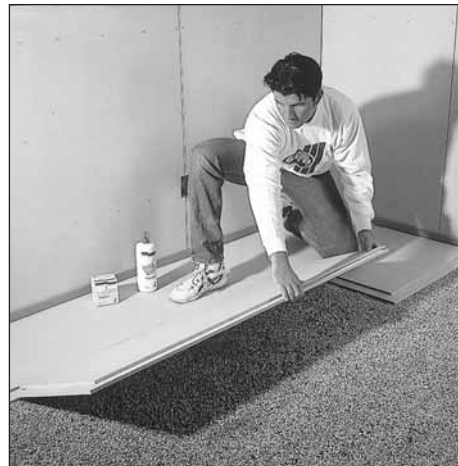
Rigidur padlóelemek fektetése
