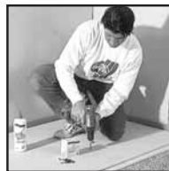
Rigidur padlóelemek összecsavározása
