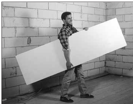
Egyemeres lap szállítása élére állítva
