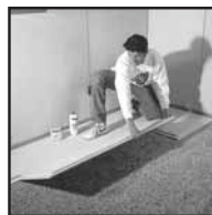
Rigidur padlóelemek fektetése
