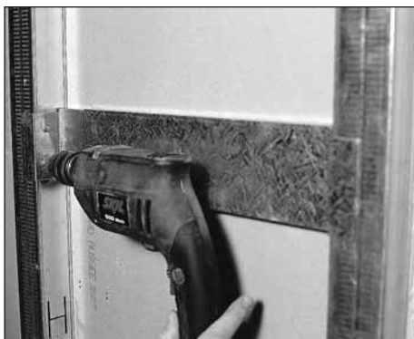
Szaniter tartóállvány beszerelés
