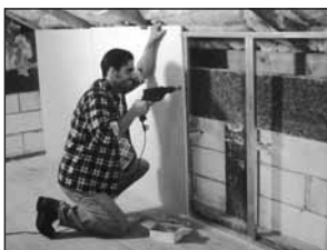
Előtétfal építés tetőtérben
