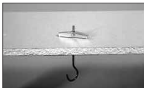
Elkerülő: a mennyezeti dübel csak a Rigips lapba kapaszkodik
