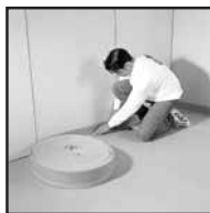
Hangszigetelő szalag elhelyezése
