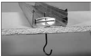
Javasolt: a dübel a profilba kapaszkodik
