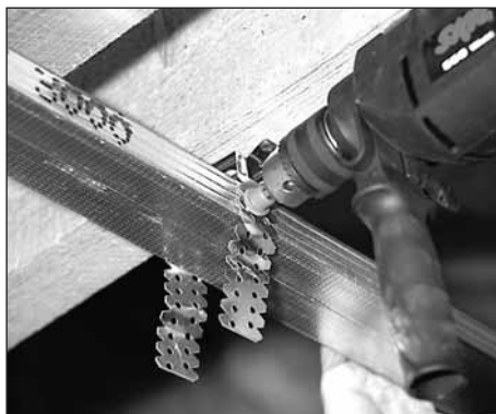
Direktfüggesztő és CD profil
