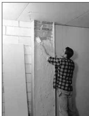
Szárazvakolat csatlakozás
