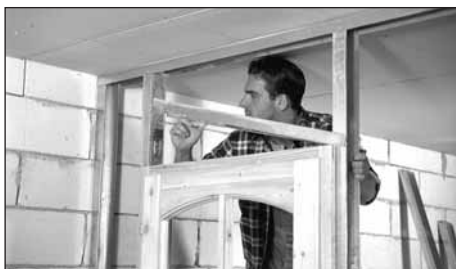
Vízszintes profil elhelyezése
