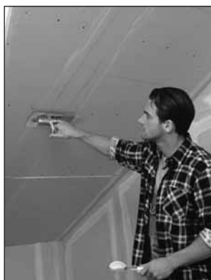
Belefektetjük a hézagerősítő csíkot
