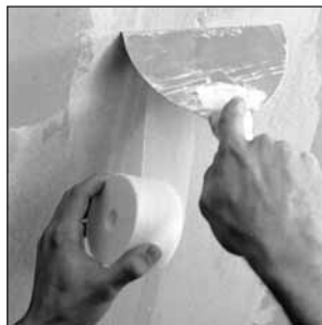
Hézagerősítő csíkok befektetése
