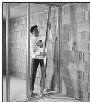
Cw profilok beállítása
