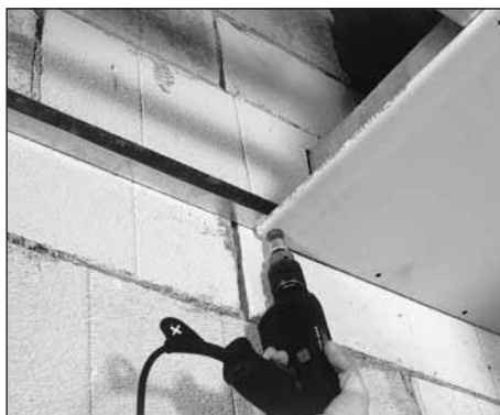
Rigips lap felszerelése
