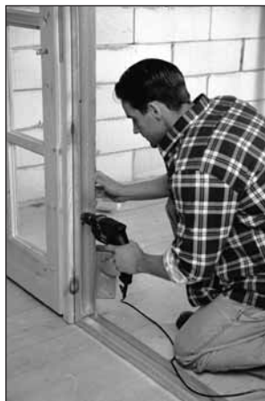
Tokszár rögzítése
